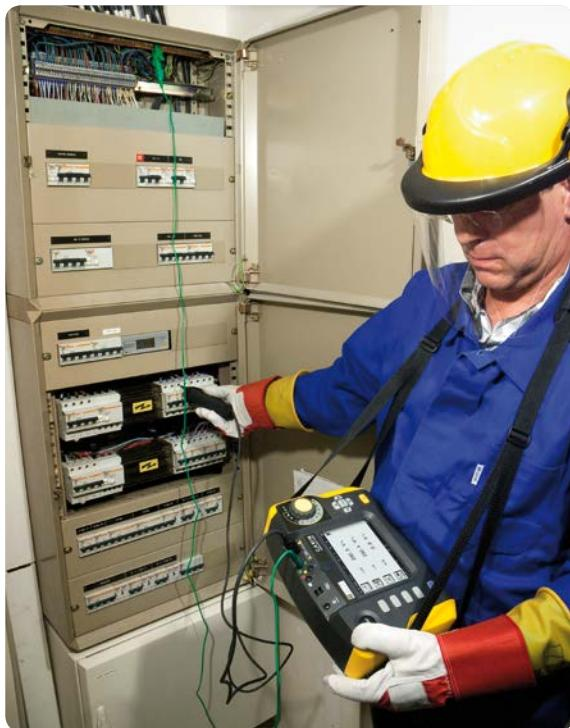
Nel settore civile, industriale o terziario i nuovi controllori multifunzione delle installazioni elettriche consentono di **verificare che l'impianto sia conforme alle norme in vigore**.
